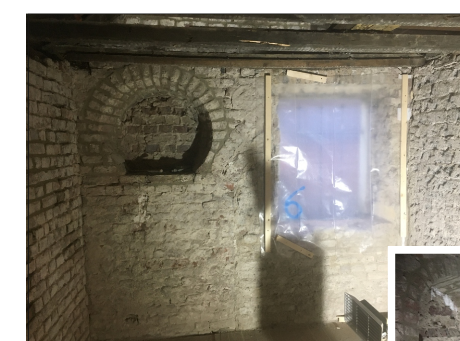
Freilegung der historischen Rundbögen
